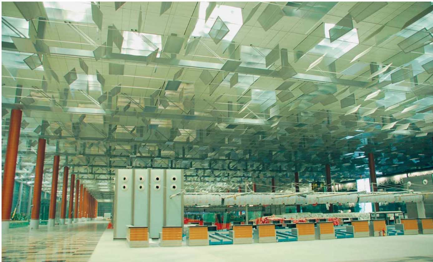
Raffinierte Tages- und Kunstlichtsteuerung: Decke des neuen Terminal 3 am Changi Airport in Singapur
